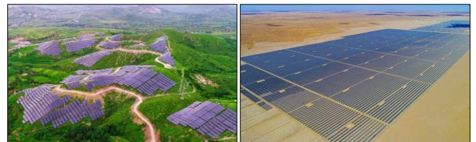
图 4. 地形起伏大时单体支架长度受限, 平坦地形则可以设计超长支架
