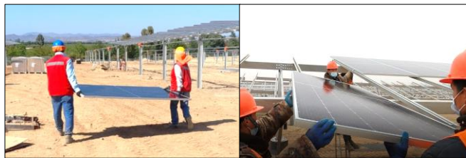
图 2. 182 组件的尺寸与重量基本达到两人便利搬运、安装的上限
